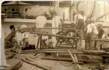
(写真上) ホーリング・マシンで海底線積込中の「南洋丸」(1937年)
