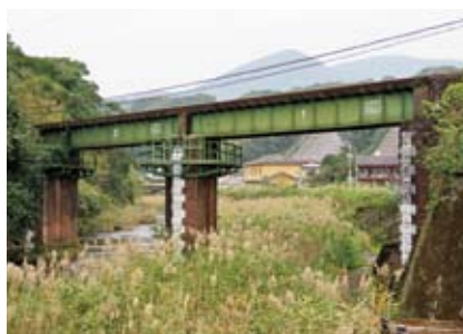
清水の瀬橋梁
