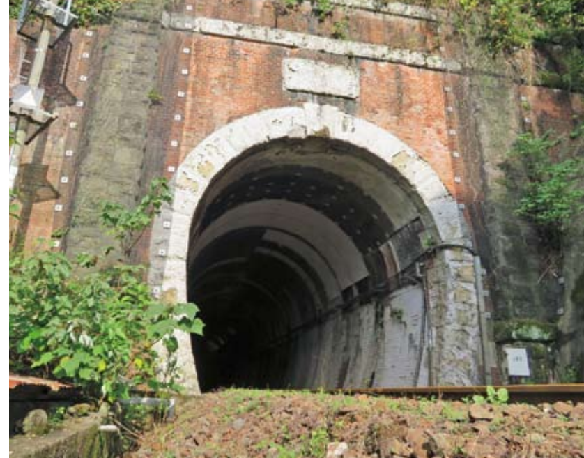
南風崎トンネル南側
