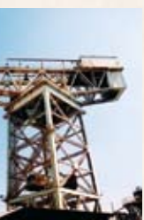
写真③ 250トンクレーン(登録文化財)
