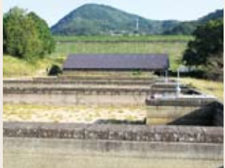
写真⑤ 山ノ田水道施設(選奨土木遺産)
