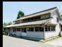
旧福幸製陶所(波佐見町) 福重家住宅主屋・旧福幸製陶所(波佐見町、国登録有形文化財) 波佐見で磁器を生産した福幸製陶所とその経営者である福重家の建物群で、いずれも昭和初期の築造。建物群の一部がカフェや雑貨店として活用されている。
